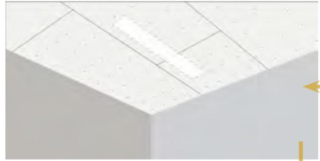
Sur la surface existante du faux plafond, tracer le gabarit de l'élément Gypsocelement
