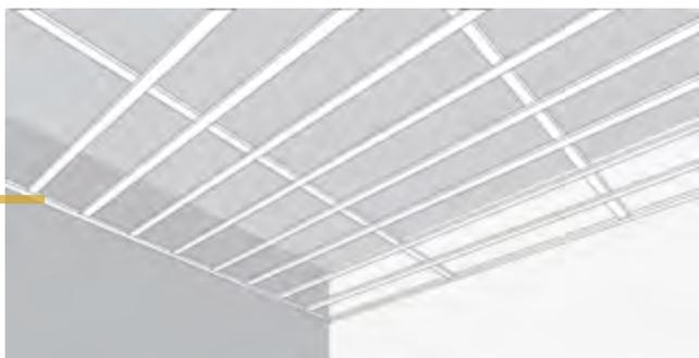
Continuer avec l'application normale de la charpente métallique et avec la pose des plaques. Sur la surface du faux plafond qui vient d'être réalisé, tracer le gabarit de l'élément Gypsocomete. Continuer ensuite de la même manière que pour l'application sur faux plafond existant.
