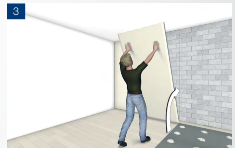
3 Positionnement des plaques de parement en plâtre sur la parois
