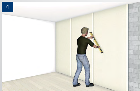
4 Alignement des plaques de parement en plâtre
