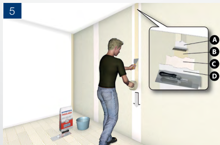
5 Traitement des joints : A - Remplissage du joint B - Pose et serrage de la bande à joint C - Recouvrement de la bande D - Enduit de finition
