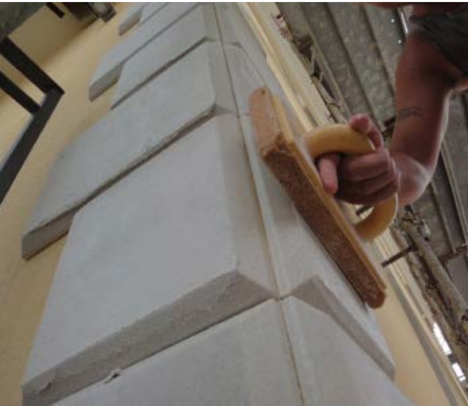
Lissage des arêtes en pierre avec A 96
