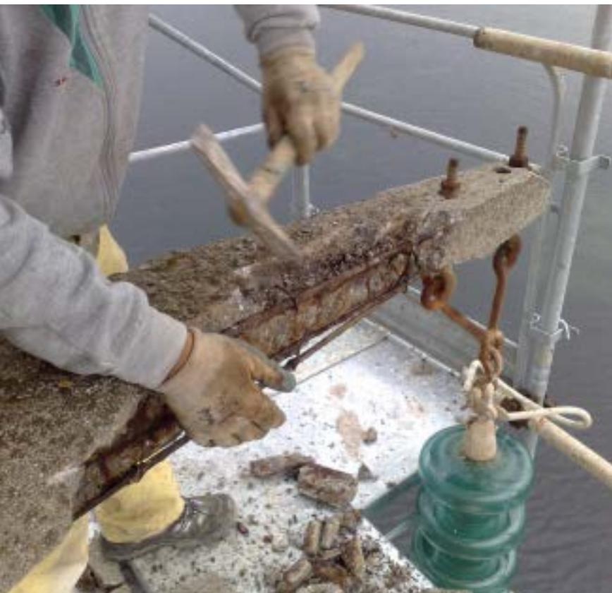
Première phase : Retrait mécanique du béton dégradé
