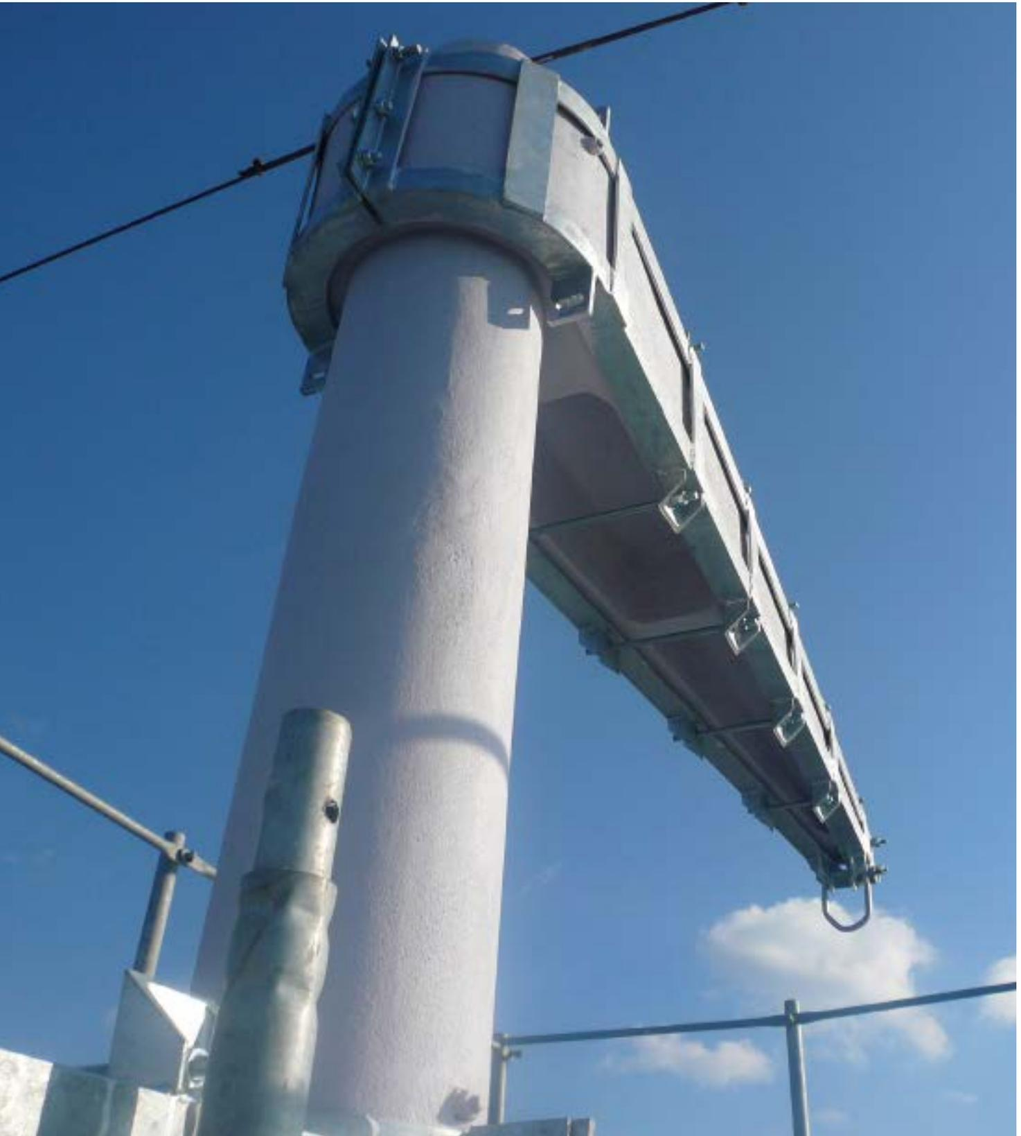
Résultat final de l'intervention, après l'application de la peinture anti-carbonatation **C 285 BETON-E**
