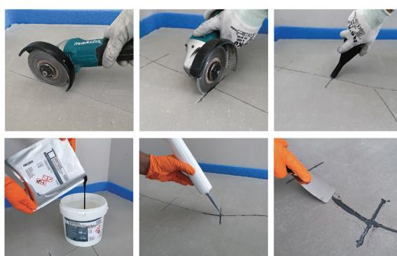
Pour le raccordement monolithique de chapes réalisées à des moments différents, appliquer FASSAFLOOR EPOXY REPAIR à l'aide d'un rouleau ou d'un pinceau sur la surface concernée par la nouvelle coulée. Pour assurer l'adhérence totale il faut avoir soin de faire pénétrer le produit dans toutes les irrégularités et porosités.
