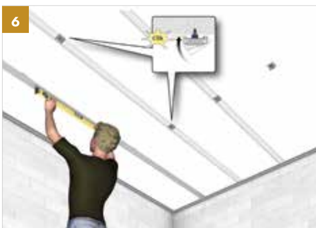
Alignement et insertion des autres montants.
