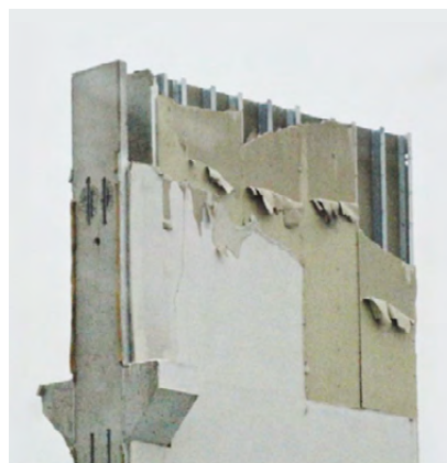
Effets de l'action sismique sur les cloisons sèches
