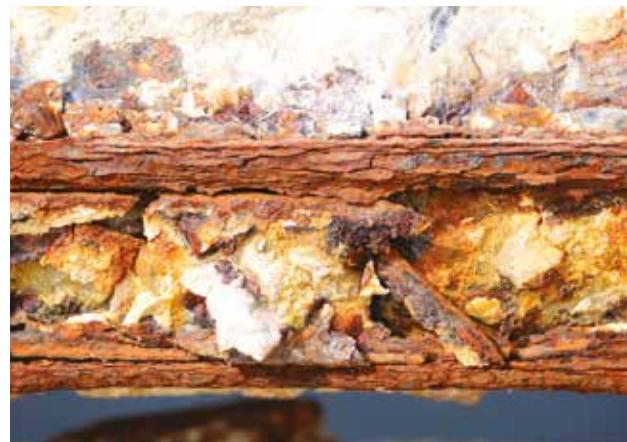
Exemple de dégradation du béton par corrosion des fers d'armature.
