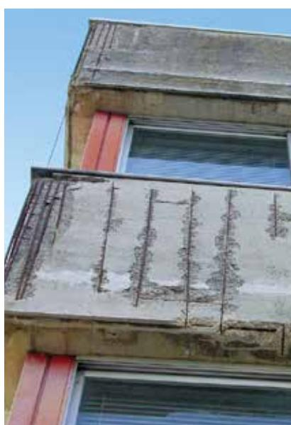
Béton avec armatures mise à nues suite à la dégradation.
