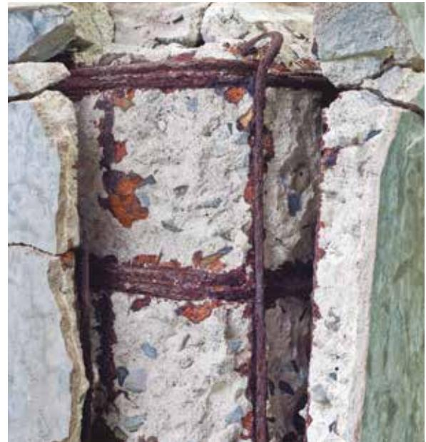
Expulsion de l'enrobage par corrosion des fers d'armature.
