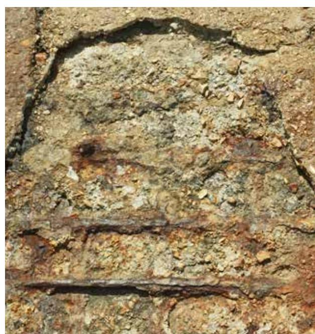
Exemple de corrosion due à l'attaque de chlorures.
