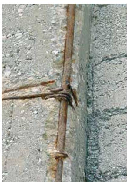
Dégénération de l'enrobage dans un pilier en béton.
