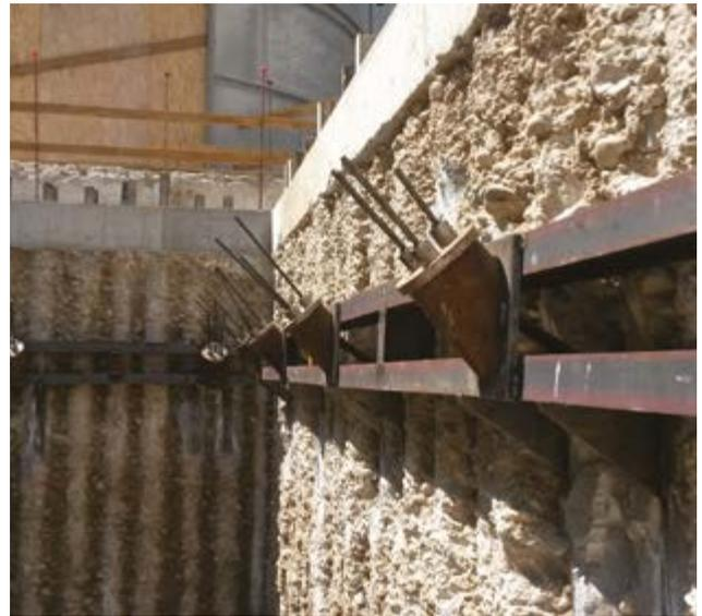
Le volume total du mélange injecté est, selon le type de sol, entre 1,5 et 3,5 fois le volume théorique du forage de logement du dispositif d'ancrage.
