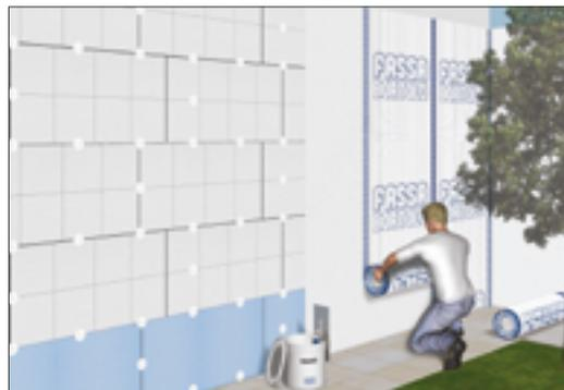
Le chevauchement des treillis d'armature, horizontalement et verticalement, doit être d'au moins de 10 et 15 cm près des bords, préalablement protégés par des baguettes d'angle en PVC, en renforcent les angles des ouvertures par des pièces obliques de treillis d'environ 35 cm x 20 cm.
