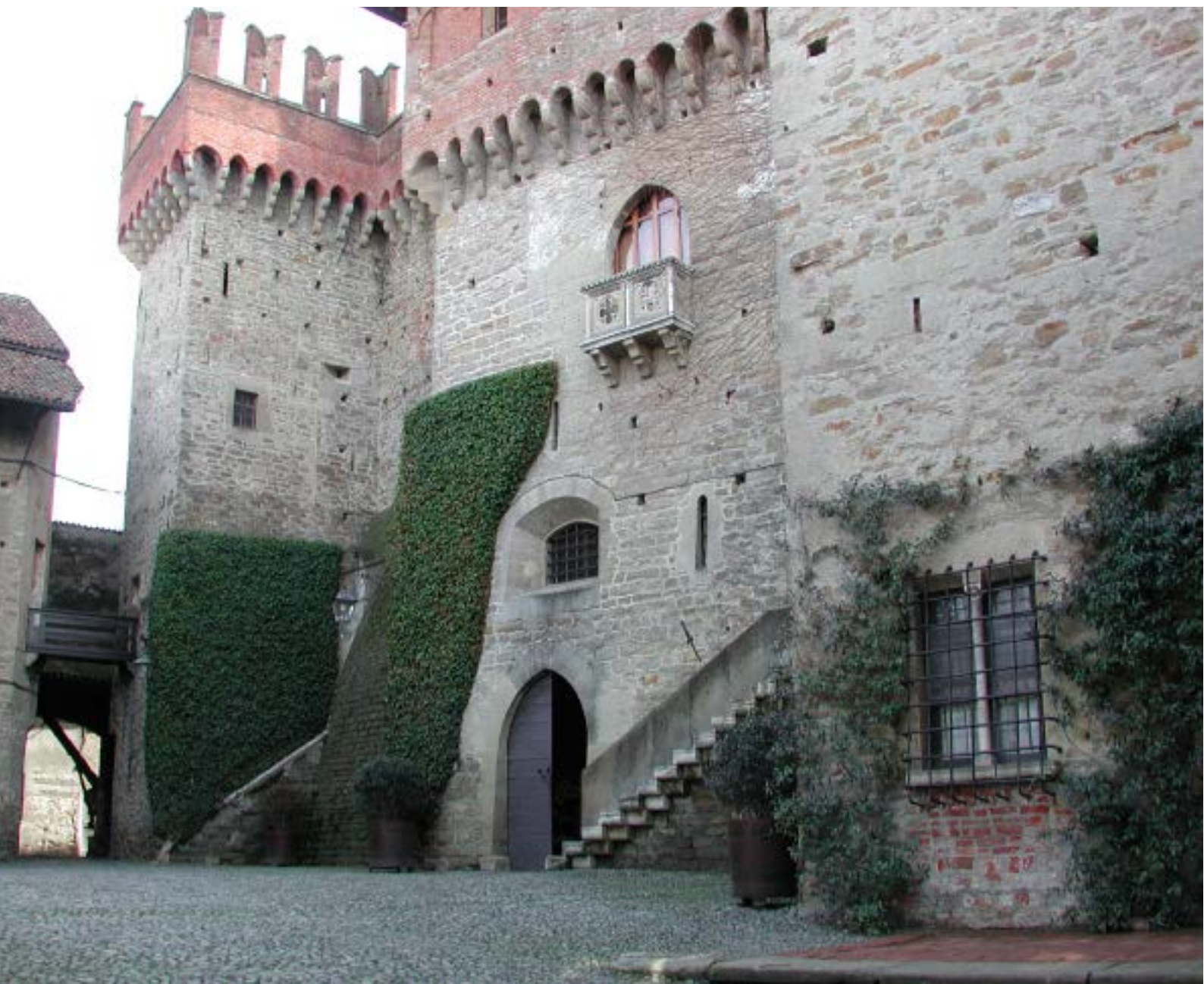
L'extérieur du château, concerné par l'intervention de restauration
