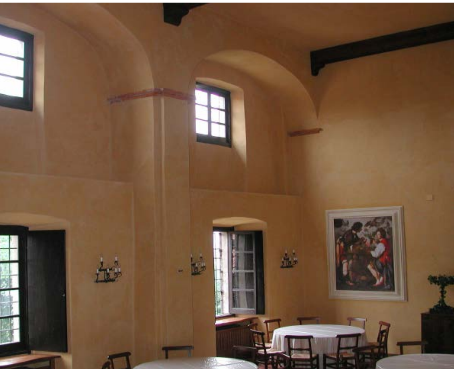
Une autre salle qui avait besoin d'une intervention radicale de récupération
