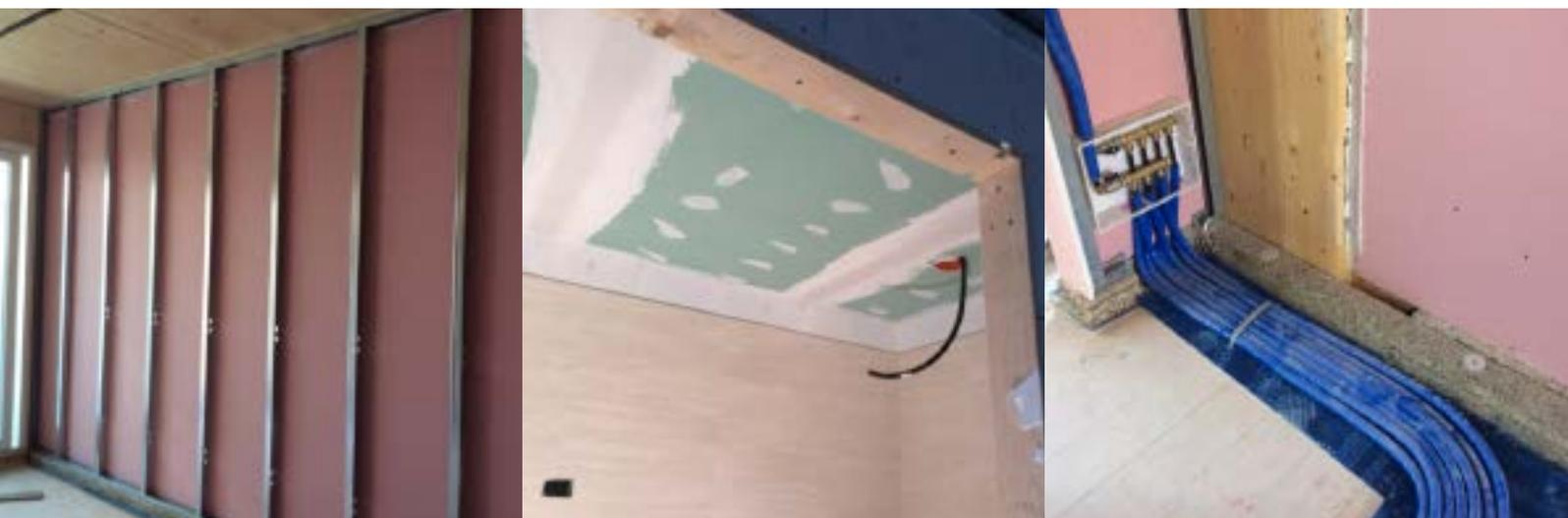
*De gauche à droite : cloison de séparation réalisée avec panneaux GYPSOTECH® FOCUS TYPE DFI, plafond réalisé avec panneaux GYPSOTECH® AQUASUPER DEH1, tuyauteries positionnées sous le plancher*
